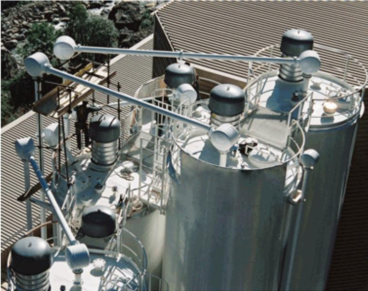
Zur Reinigung der Rauchgase aus einer Müllverbrennung werden Hilfsstoffe, wie Kalkhydrat und Aktivkohle eingesetzt. Eine Gruppe von Silos, in die diese Produkte von einem Silofahrzeug eingeblasen werden, sind mit **INFA-JETRON AJB Silofilter** ausgerüstet, um den Staub aus der Förderluft heraus zu filtern. Die Abreinigung der Filterelemente erfolgt pneumatisch durch kurze Druckluftstöße.
