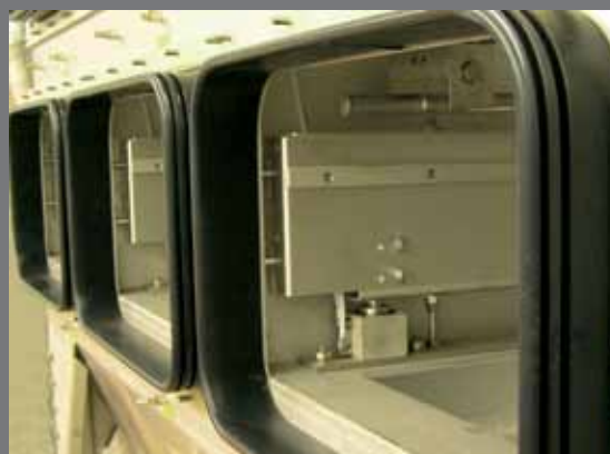
„Safe Change“ Wechselkragen für Filterkassetten
