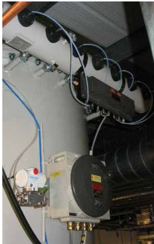
Druckgekapseltes Steuergerät und Magnetventilkasten für ATEX-Zone 1
