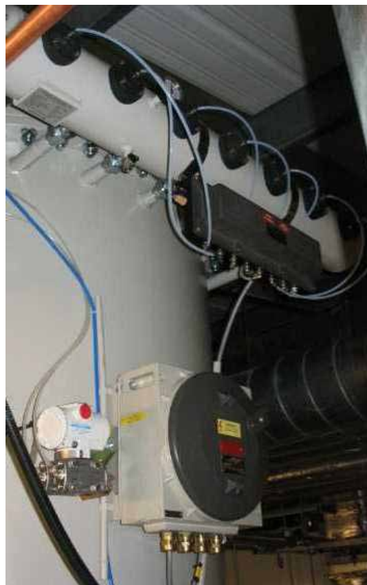
Druckgekapseltes Steuergerät und Magnetventilkasten für ATEX-Zone 1
