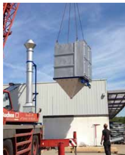
Montage eines Taschenfilter AJN 2/603 SL
