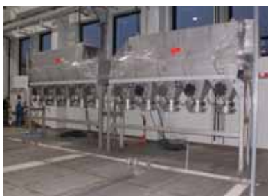
Die Kassettenfilter kurz vor Montage und Inbetriebnahme
