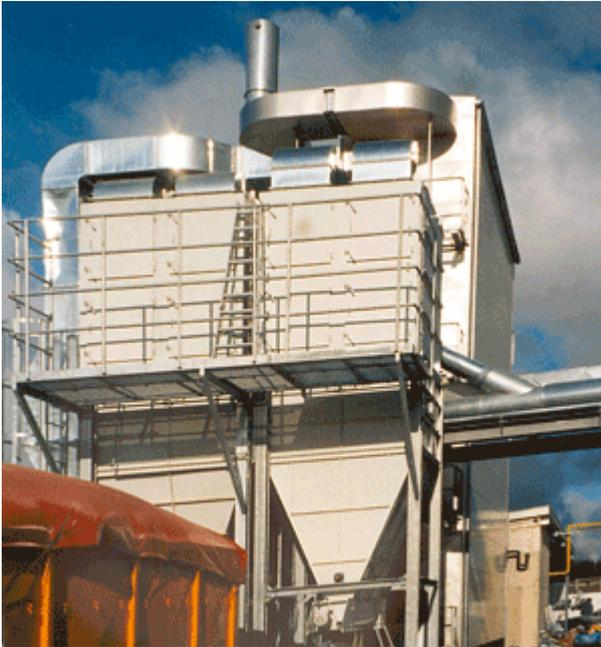
Bei der Herstellung von Schreib- und Kosmetikstiften wird die Holzhülle auf Fräsmaschinen angespitzt. Die dabei anfallenden Holzspäne werden an den Maschinen abgesaugt und in einem zentralen **INFA-JET Entstaubungsgerät** abgeschieden. Dem Filter nachgeschaltet ist eine Brikettieranlage, in der die Späne kompaktiert werden.
